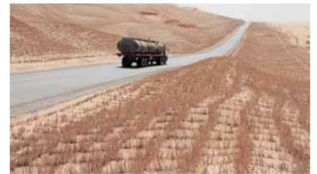
タクラマカン砂漠(中国)で道路に沿って作られている草方格。砂で道路が埋もれるのを防ぐ。
