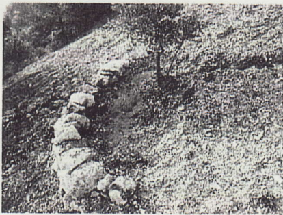
農家が施工した石積みによる土壌浸食防止工。斜面を流れる雨(地表流)によって運ばれた土砂を、石積みでせき止めて土壌浸食を防止する。地表流によって溝状に削られた土砂が、石積みの手前に堆積(たいせき)している
